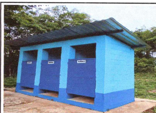
Foto 4: Finalizaciòn de entechado nuevo y pintura nueva del baño escolar
